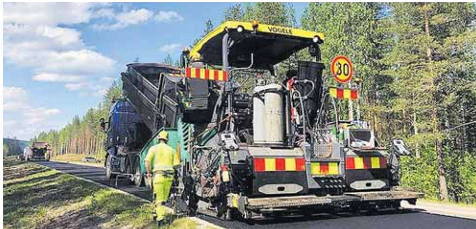
Päällystetyn tieverkon ylläpitotyöt muodostuvat teiden uudelleen päällystystöistä, päällysteiden paikkauksista sekä tiemerkintöjen kunnostamisesta.
