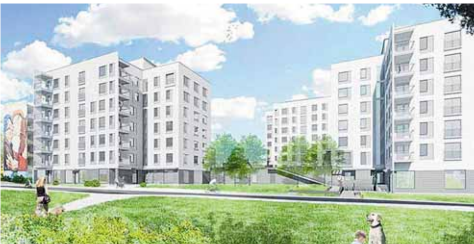
Asuntosäätiön ensimmäinen maalämpöä käyttävä kerrostalokohde on rakenteilla Espoon Karakallioon.
